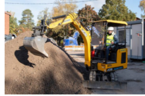
Päästöttömän työmaan konseptin pilotointi Helsingissä.
